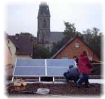
Installation der Solaranlage im Jahr 2004
