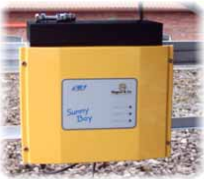
Der Spannungswandler, der an die Photovoltaikanlage angeschlossen wird
